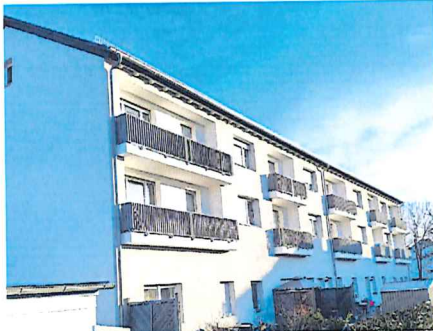
Neue Heimat für Mitarbeiter: 15 Wohnungen hat Gebäudereinigermeister Markus Wasserle gekauft. Wo eine Wohnung frei wird, dürfen Mitarbeiter einziehen. Sie zahlen eine Miete, die 30 Prozent unter dem üblichen Marktpreis liegt. Fotos: Barbara Oberst
